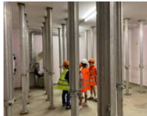
Visite de chantier © Patrimoine suisse Genève
