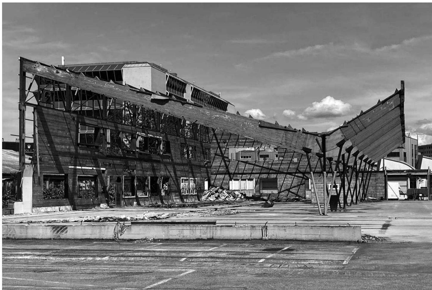
Les entrepôts en bois à la route des Jeunes, réalisés par les architectes Lozeron et Mozer en 1960, en cours de démolition.
