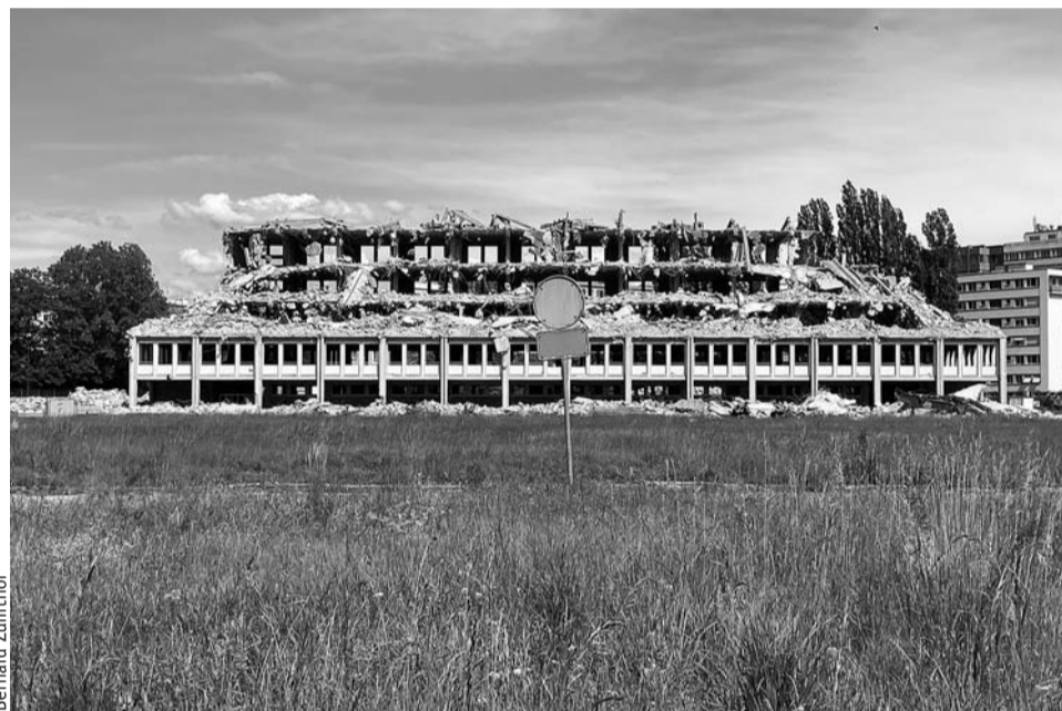
La caserne des Vernets (PAV) en cours de démolition.
