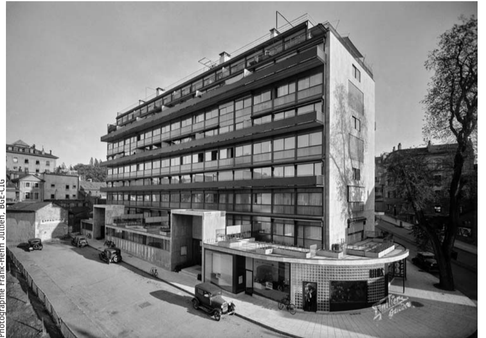
Vue générale de la façade nord de l'immeuble Clarté, février 1934.
