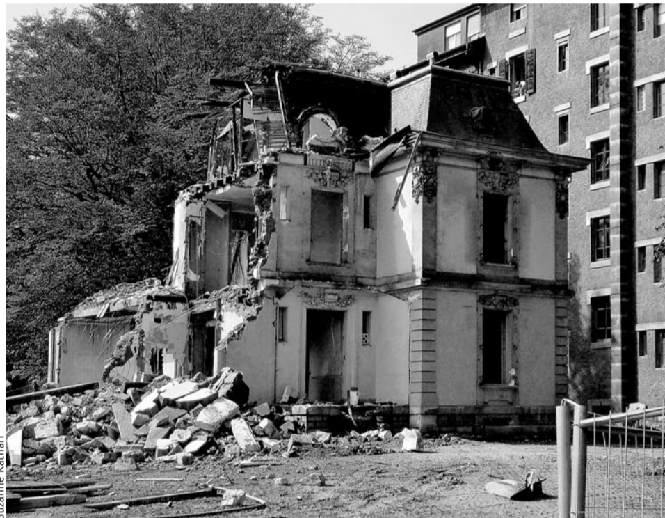
Etat de la démolition au 2 mai 2013.
