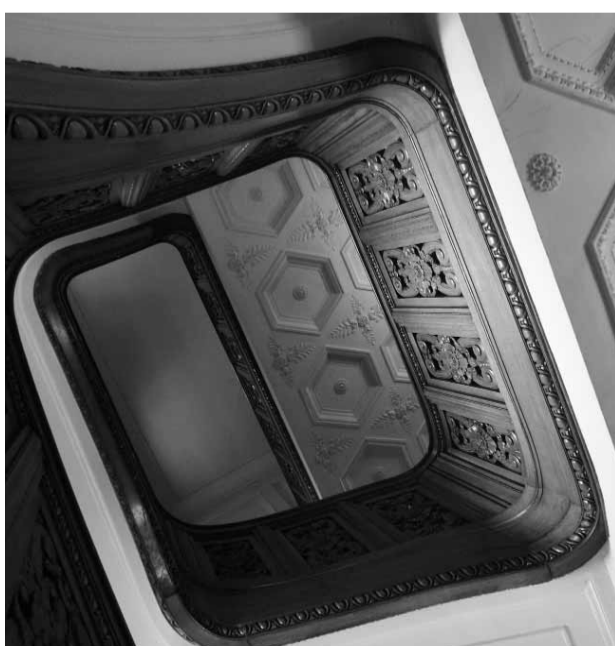
L'escalier avec sa balustrade en bois sculpté et ses plafonds à caissons, rosettes et palmettes.
