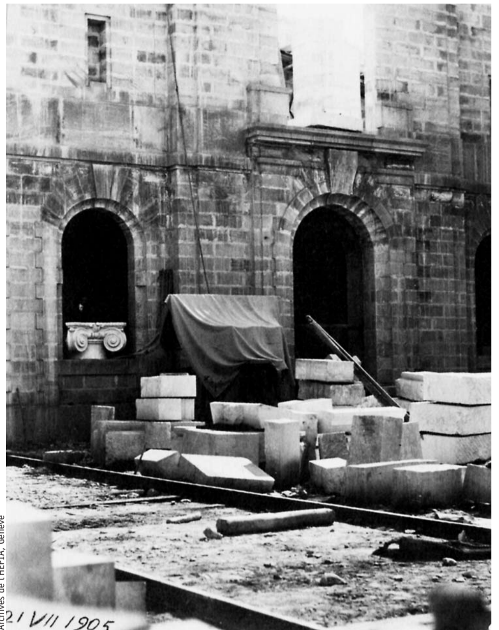
Les matériaux du gros-œuvre en attente dans la cour du musée.
