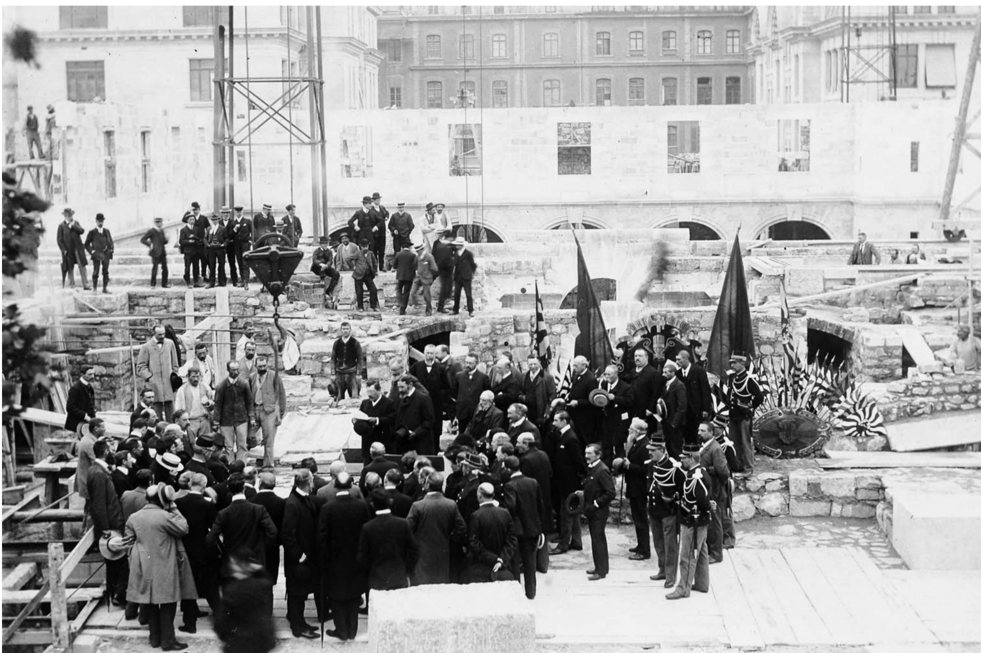
Cérémonie officielle dans la cour du musée en construction.
